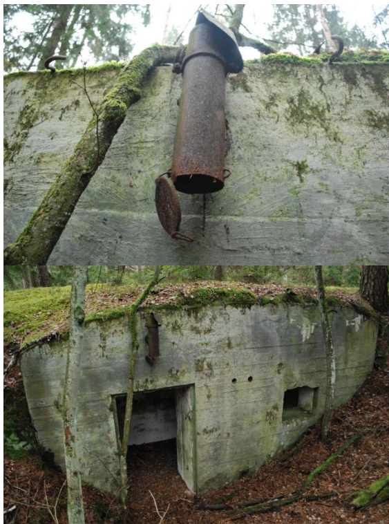
Obiekt nr 43, zachowana rura kominowa (u góry po lewej), ambrazura – ukształtowanie otworu strzelnicy osłony wejścia (góry po prawej), elewacja zewnętrzna (u dołu po lewej), schemat schronu (u dołu po prawej).
