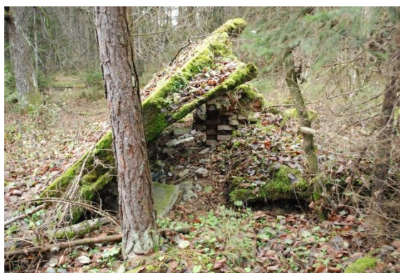
Obiekt nr 42, ruiny blokhauzu murowanego. Widoczne łukowate fragmenty stropu oparte o resztki piecyka z cegły.
