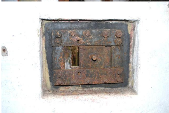
Obiekt nr 51, elewacja zewnętrzna (na górze), numer wymalowany przy drzwiach zewnętrznych przedsionek schronu oraz zachowane futryny drzwi (pośrodku), elementy wyposażenia; zasuw strzelnicy (po lewej na dole), zasuw przewodu wentylacyjnego (po prawej na dole).
