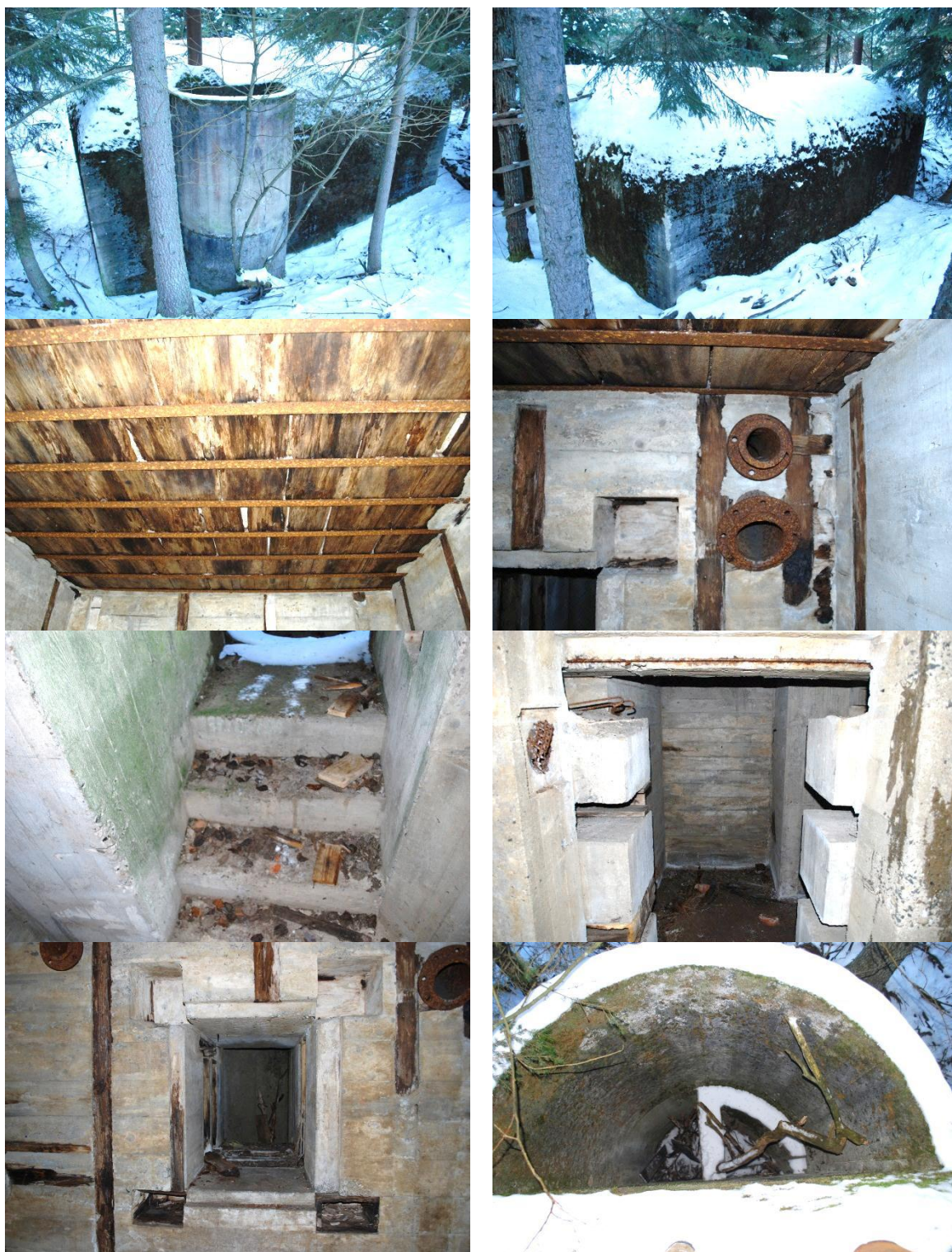
Regelbau 668, uniwersalny schron bierny, nieosypana ziemią bryła schronu widoczna owalna klatka schodowa (u góry), strop i przewody wbetonowane w konstrukcje schronu, (poniżej) schody wejściowe i otwór drzwiowy do służby przeciwgazowej (poniżej), otwór drzwiowy wyjścia ewakuacyjnego i wnętrze klatki schodowej (na dole), schron znajduje się w oddziale 1s.
