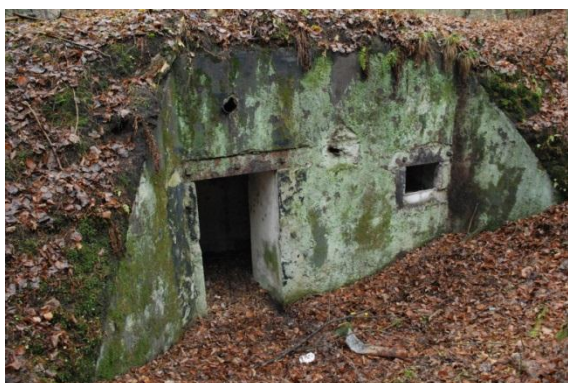
Obiekt nr 53 1928 rok, elewacja zewnętrzna z orylonami (po lewej), prowadnice zasuw strzelnicy osłony wejścia (z prawej).
