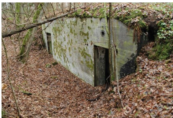
Obiekt nr 54, elewacja zewnętrzna i płyta osłaniająca strzelnicę osłony wejścia.
