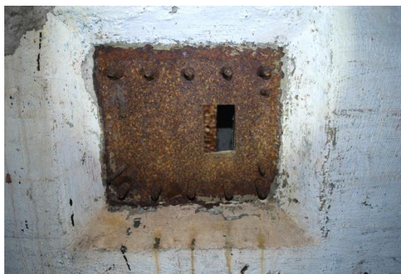
Obiekt nr 54, elewacja zewnętrzna i płyta osłaniająca strzelnicę osłony wejścia.
