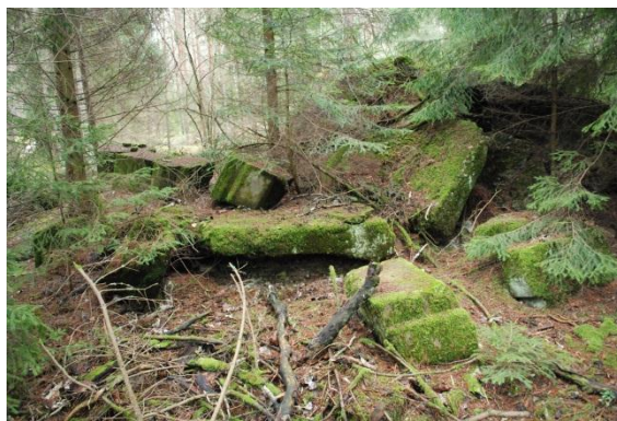
Obiekt nr 48, ruiny blokhauzu murowanego. Widoczne łukowate fragmenty stropu.
