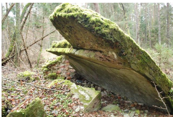
Obiekt nr 42, ruiny blokhauzu murowanego. Widoczne łukowate fragmenty stropu oparte o resztki piecyka z cegły.
