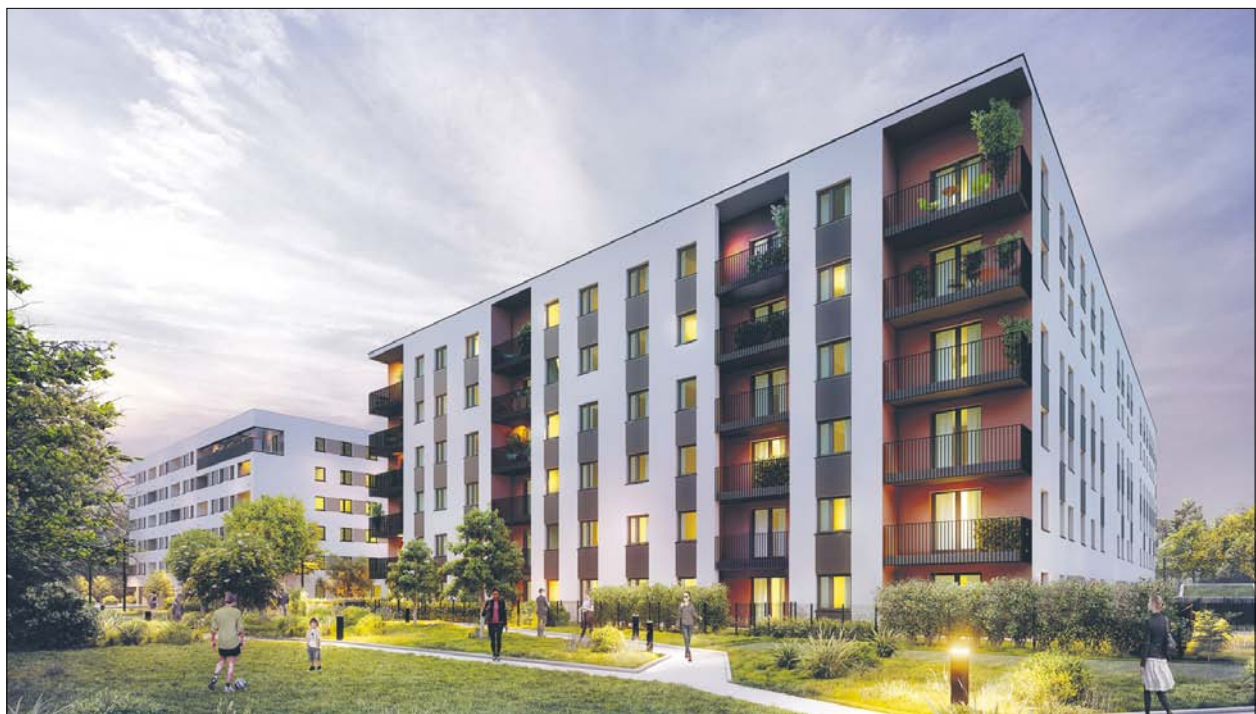
Inwestycja City Vibe na Małym Płaszowie w Krakowie. Budynek City Spot
